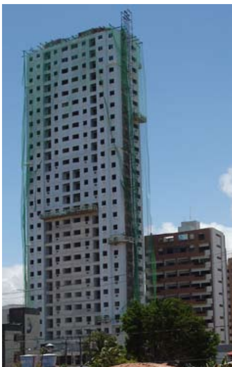
Curso prevê visitas a canteiros de obras
